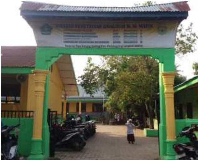
Tampak Depan Sekolah MTSS Awaliyah
