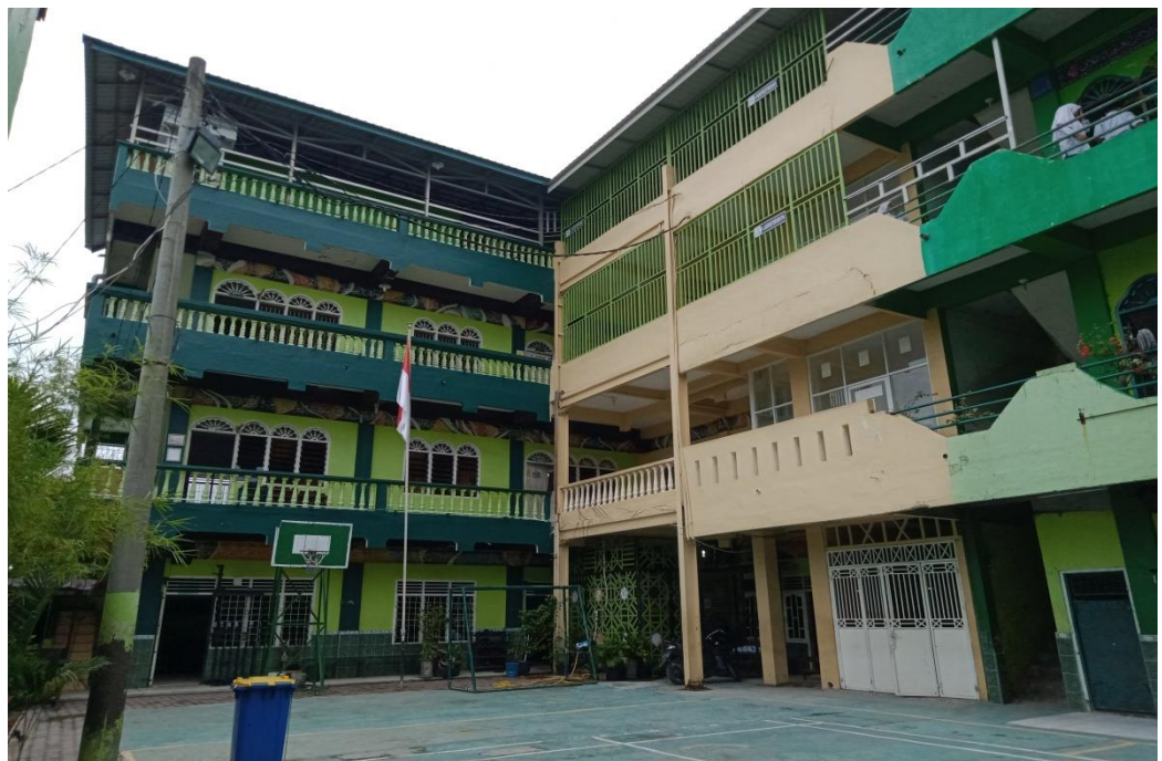
Gambar 2. Bangunan MTs Al-Jamiyatul Washliyah Tembung
