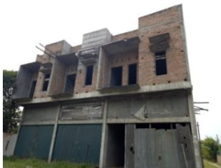
CV. Bintang Angkasa Proyek konstruksi rumah toko Lokasi : Deli Tua
