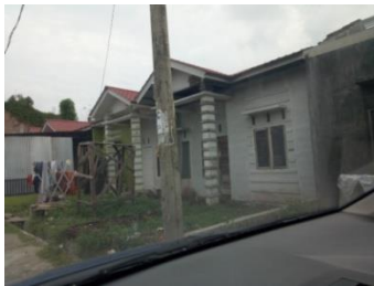
CV. Kharisma Graha Proyek konstruksi perumahan Lokasi : Namorambe
