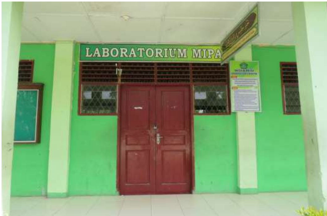
Ruangan Lab. MIPA (tampak luar)
