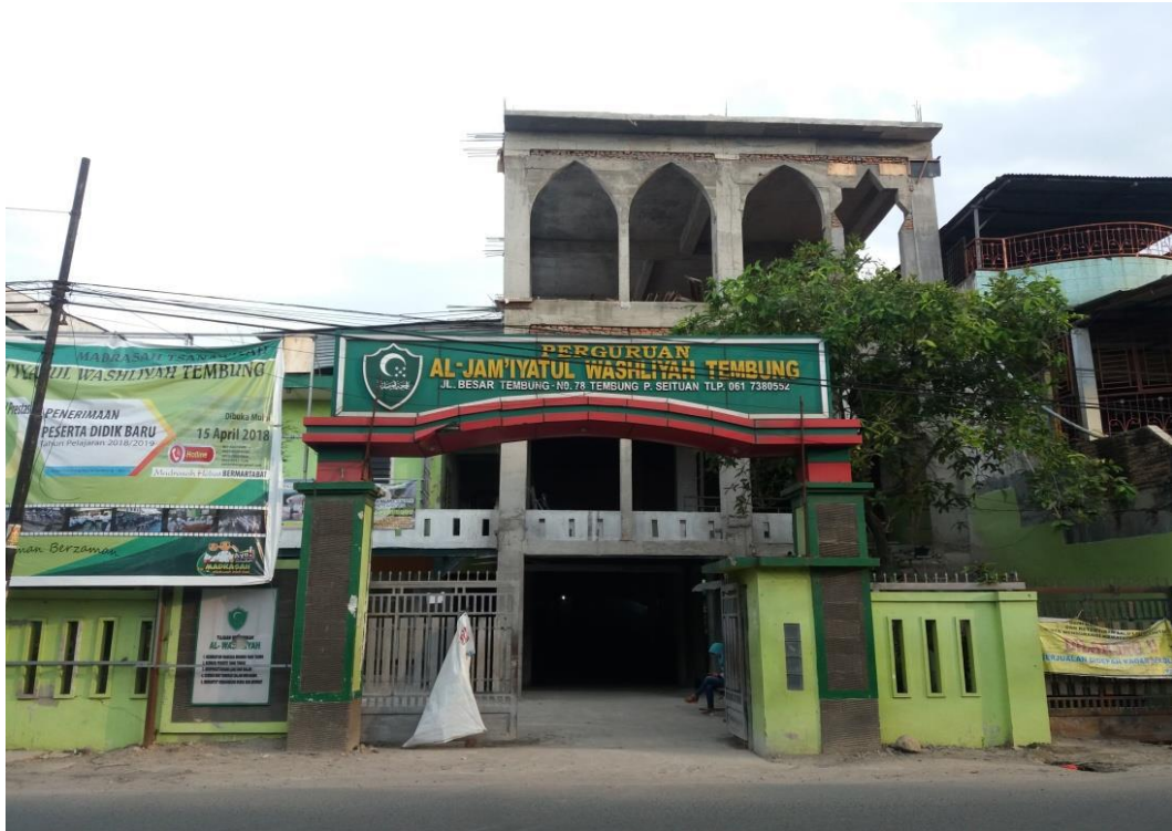
Gambar 1. Bangunan MTsS Al-Washliyah Tembung dari Luar
