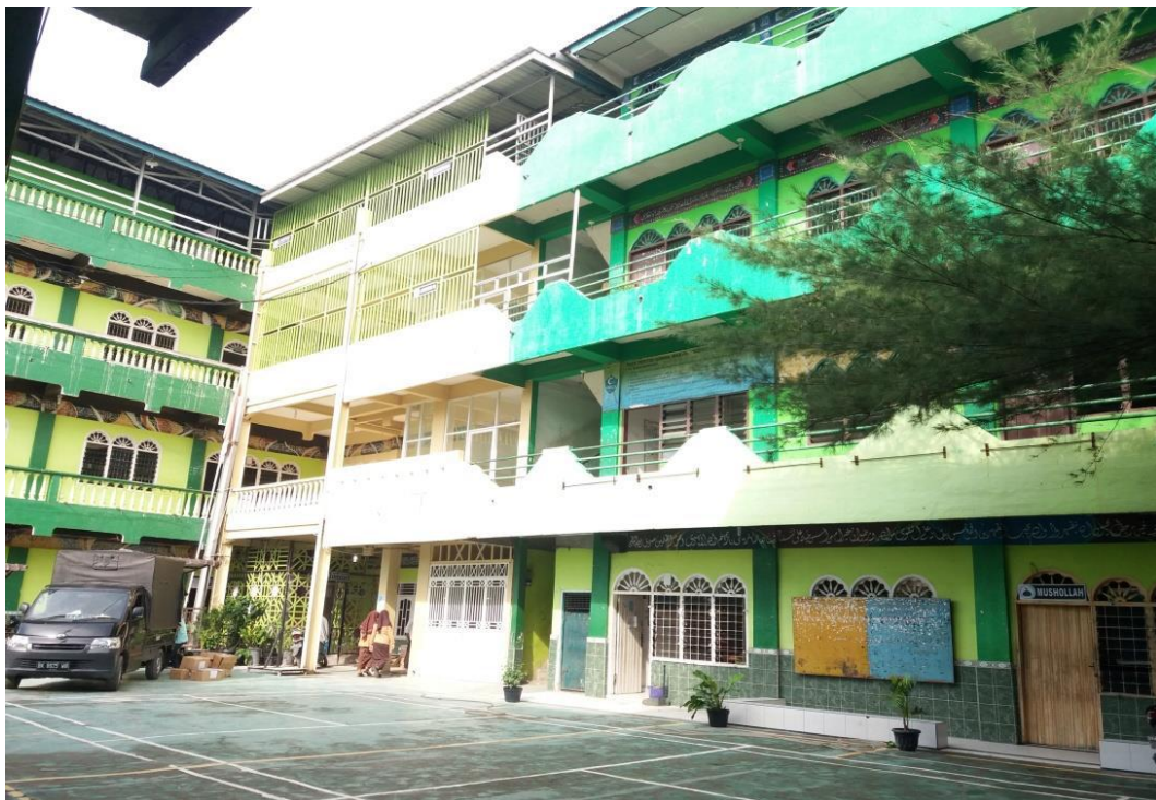
Gambar 2. Bangunan MTsS Al-Washliyah Tembung dari Dalam
