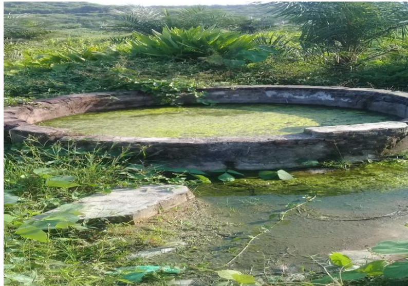
Foto Sumur Luber Foto Sumur Luber
