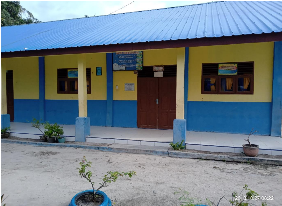
Ruang perpustakaan SMP Negeri 5 Satu Atap Medang Deras
