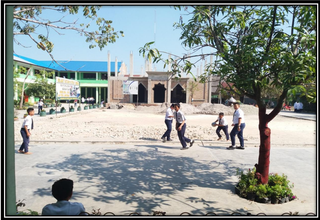
Pembangunan masjid Mts N 2 Medan
