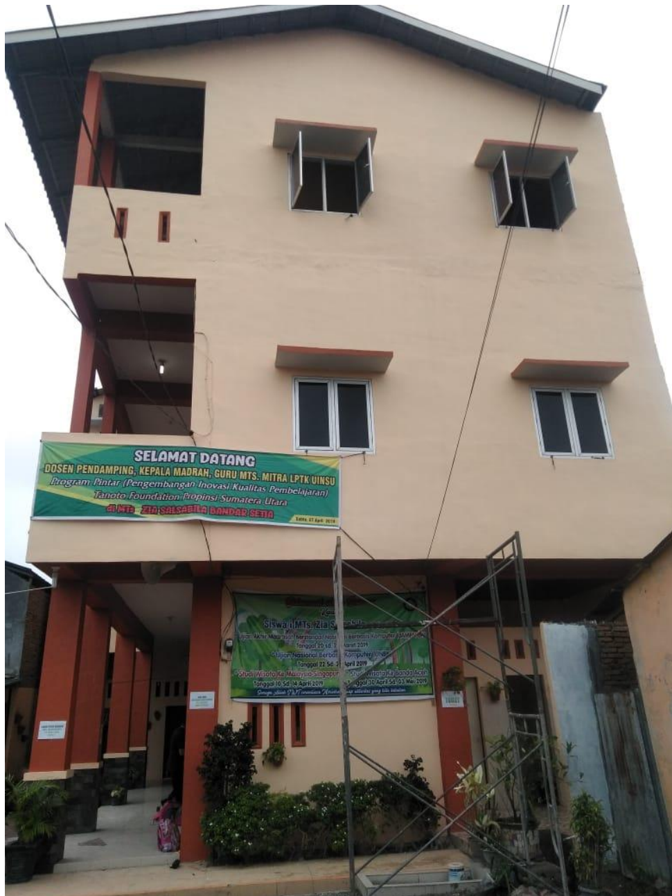
Foto Gedung Sekolah Tampak Depan yang terdiri dari 3 lantai ruang belajar
