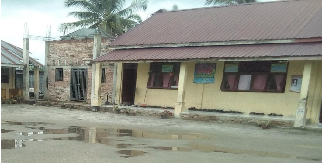
Gambar. 4.3. Ruang Guru yang Belum Selesai (Bangunan sebelah Kiri)
