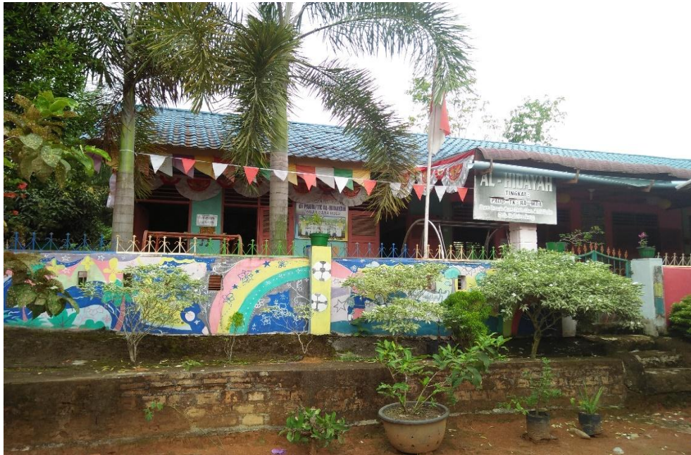
Gambar 4.1 Bangunan sekolah RA Al-Hidayah tampak dari depan
