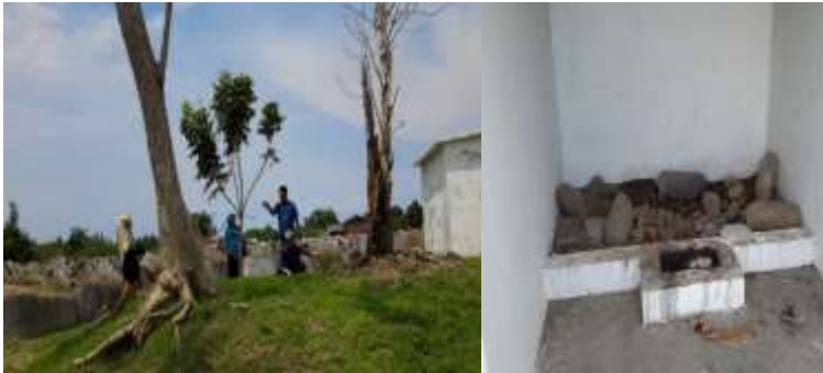
Gambar 15: Kondisi Kompleks Makam Datuk Payung
