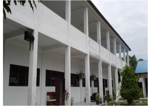
GEDUNG MADRASAH TAMPAK DARI SAMPING
