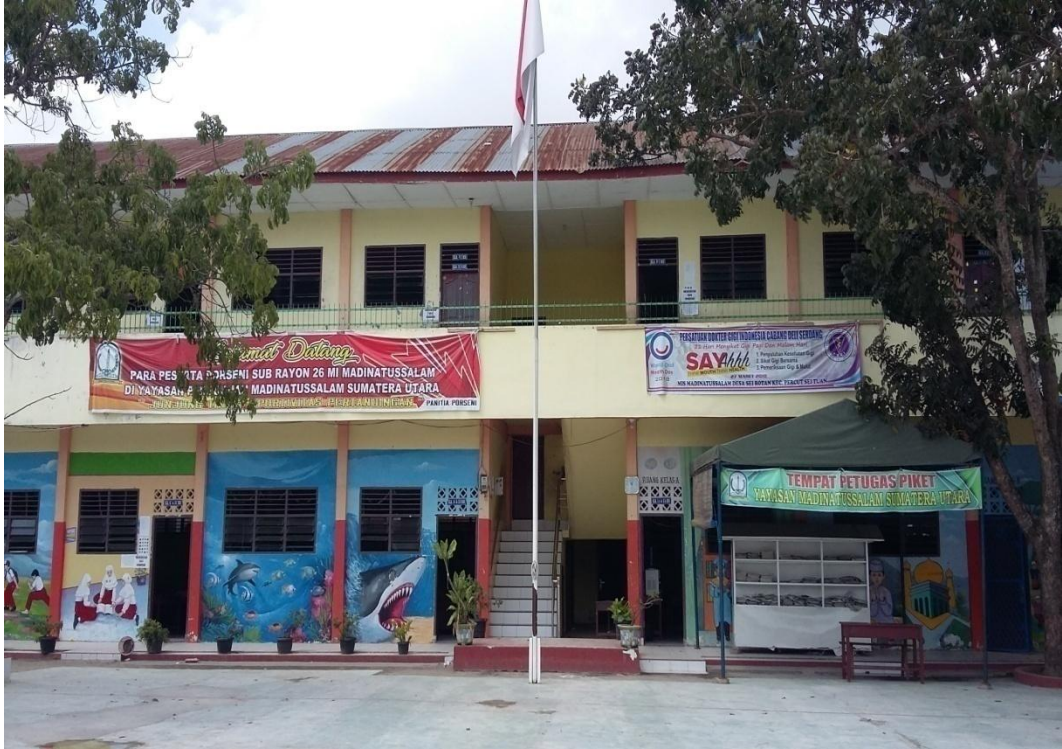
Gambar 3. Ruang Kantor dan Ruang Kelas
