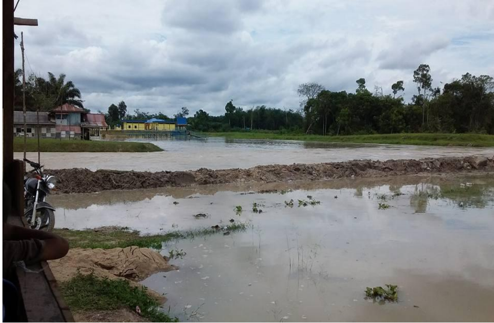
Penampungan air yang akan di kelola dan perbaikan pipa yang rusak untuk di salurkan ke masyarakat.
