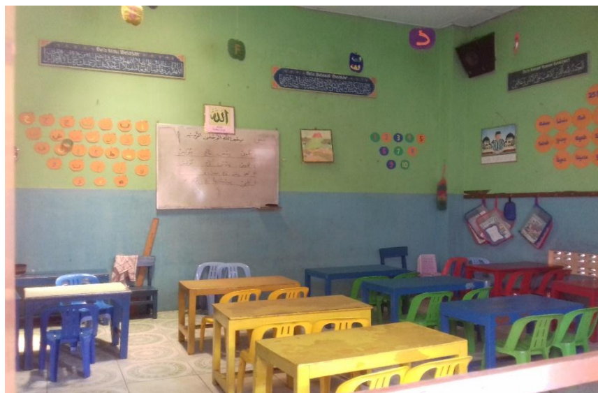
Gambar 4.3 Kondisi Ruang Kelas
