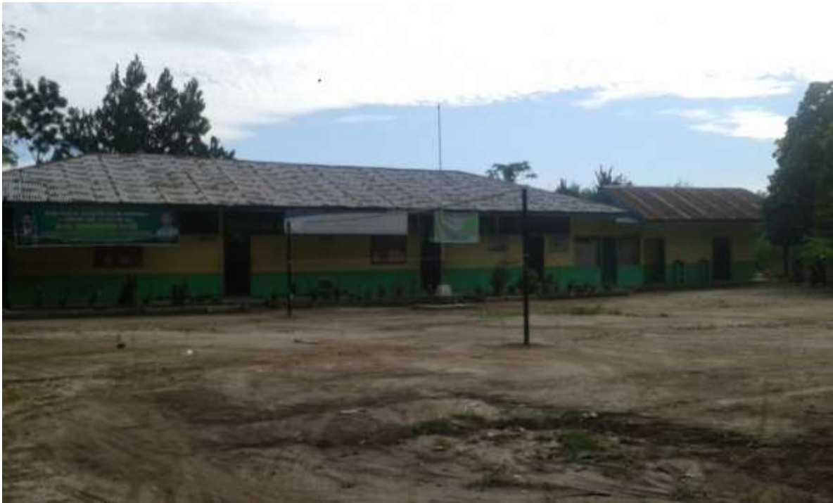
Bangunan Sekolah/Yayasan MTs. Al-Ikhlash Korajim dan Lapangan Bola Voli
