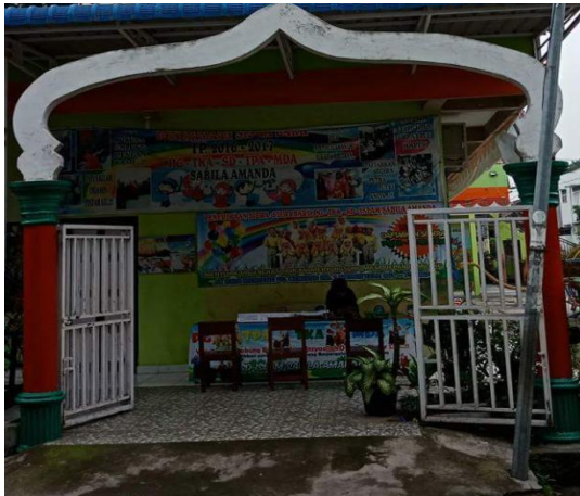
Bangunan depan sekolah
