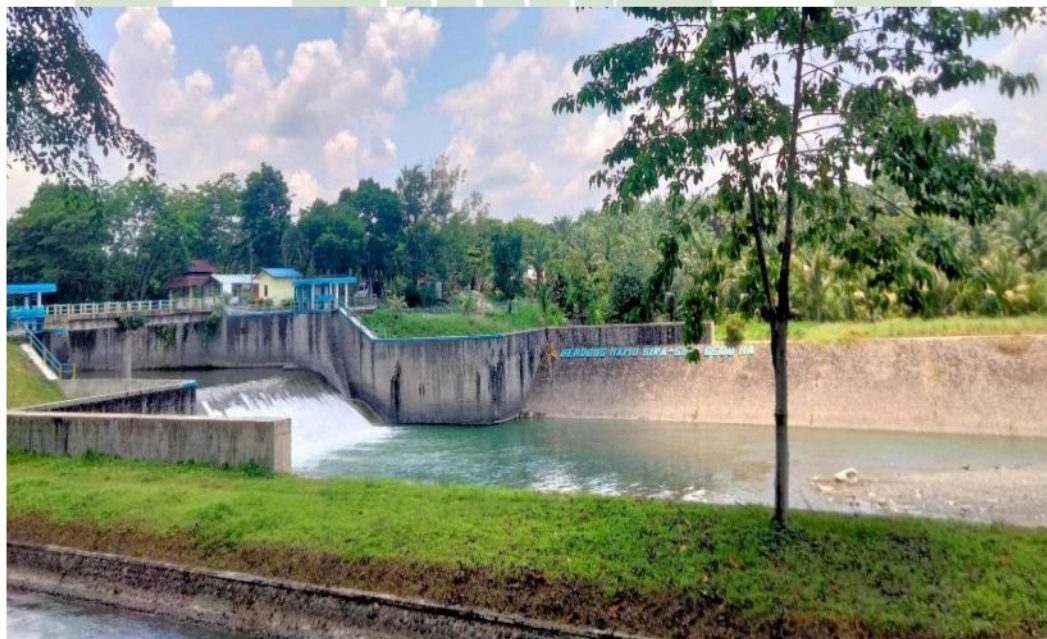
Gambar 3.7. Bendungan Namu Sira – Sira (Stasiun 3). Sumber: Dokumentasi Pribadi
