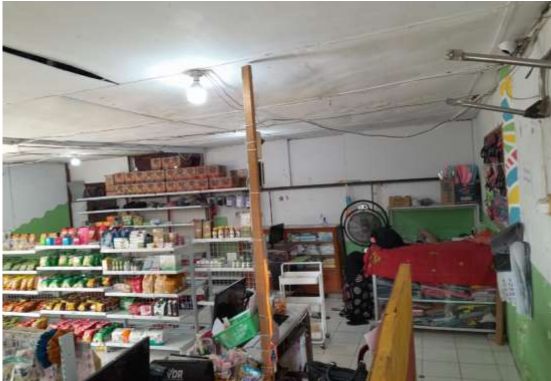
Foto dokumentasi Kantin
