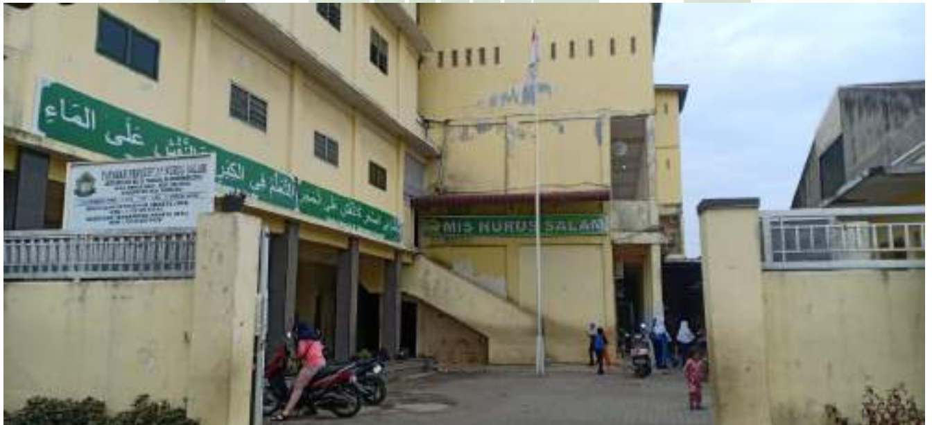
(Gedung Sekolah Tampak depan)
