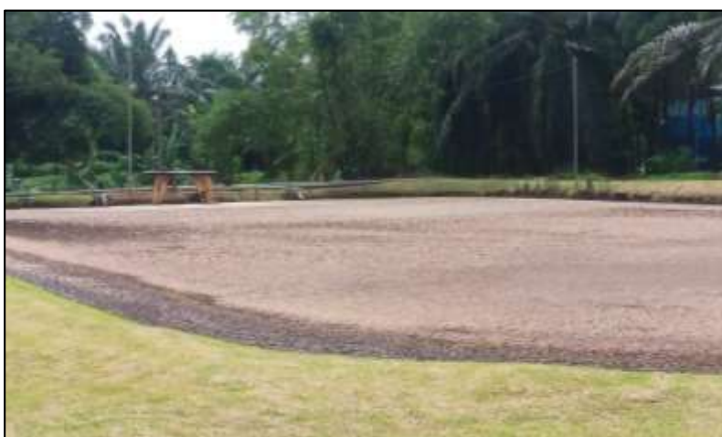
Gambar 2. Instalasi Pengolahan Air
