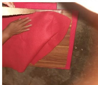
Gambar 4. 8 Menempelkan kain flanel pada triplek penutup
