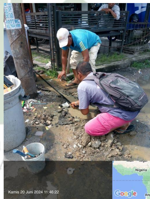
Pemasangan pipa air ke rumah pelanggan
