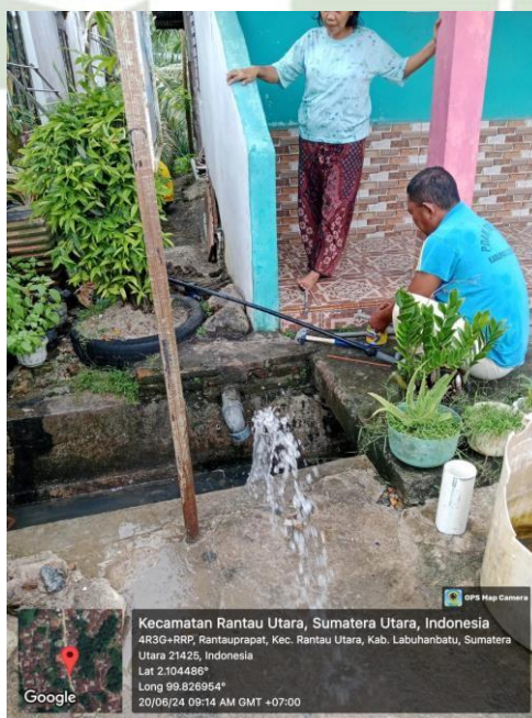
Pemasangan pipa air ke rumah pelanggan
