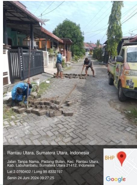
Pemasangan pipa air pada pelanggan
