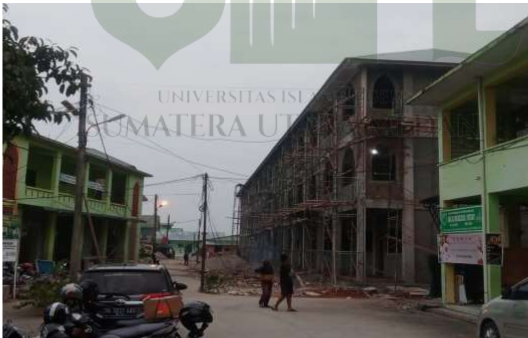
Pembangunan Biro Rektor dan Ruang Kelas Baru
