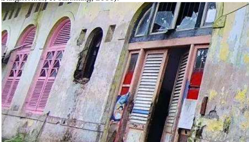
Gambar 6. Jendela dan Pintu (Sumber: Dokumentasi Pribadi, 2023)
