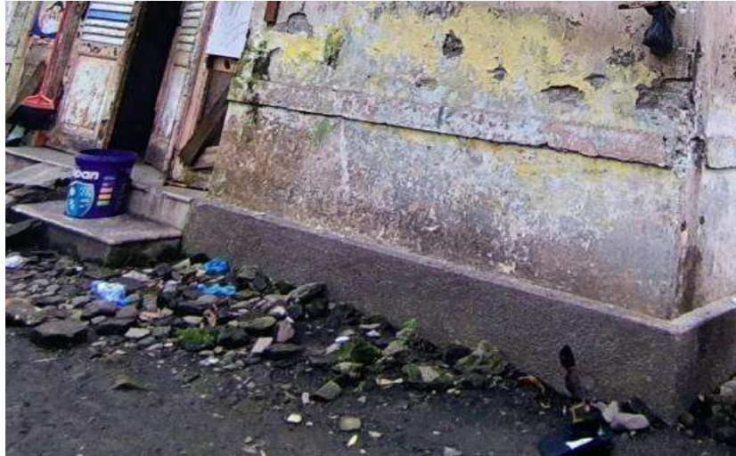
Gambar 7. Pondasi Lebih Tinggi dengan Penonjolan Motif Batu Alami (Sumber: Dokumentasi Pribadi, 2023)
