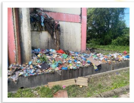
Gambar 3. Kondisi Sarana Pembuangan Sampah
