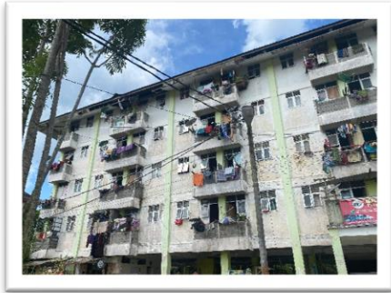
Gambar 1. Kondisi Fisik Rumah
