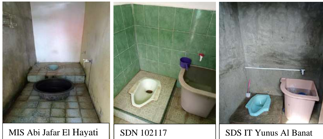
Gambar 1. Jamban Responden Dan Tempat Penampungan Air Bersih
