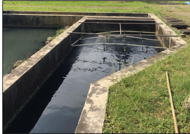
Gambar 14. Skimming Tank (Sumber: Dokumentasi Pribadi)
