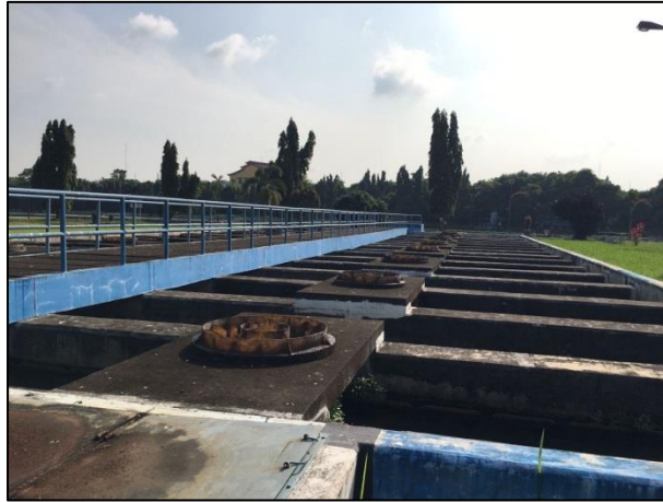
Gambar 12. Reaktor UASB (Sumber: Dokumentasi Pribadi)
