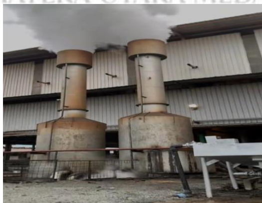
Gambar 2.4 Pencemaran Udara Oleh Cerobong Pabrik
