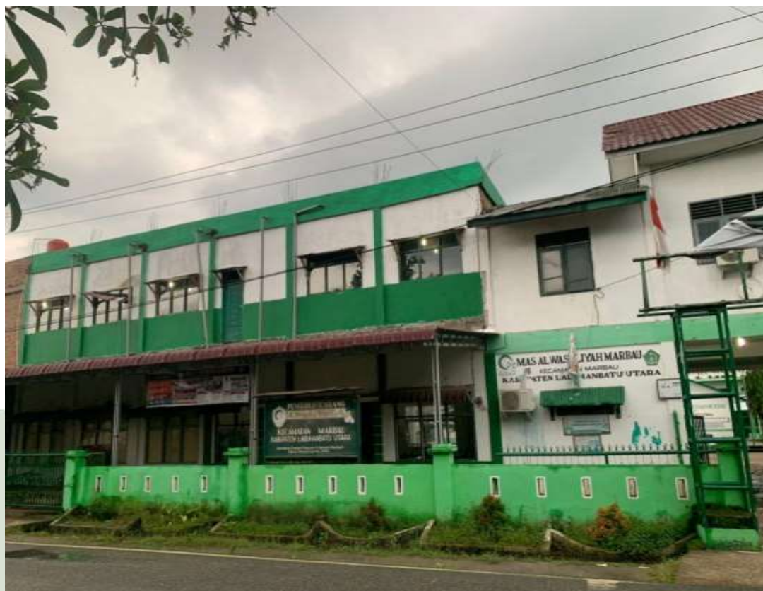
Gambar 4. 1 Bangunan Luar MAS Al Washliyah Marbau
