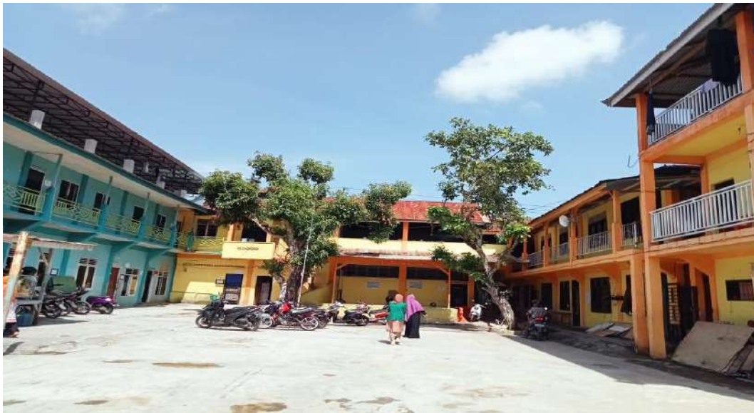
Gambar 1. Bangunan MAS Islamiyah Guntung saga Kabupaten Labuhanbatu Utara.
