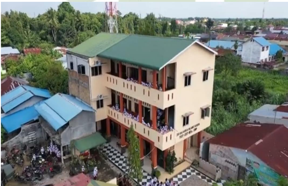
MTs Zia Salsabila Sebelum Renovasi
