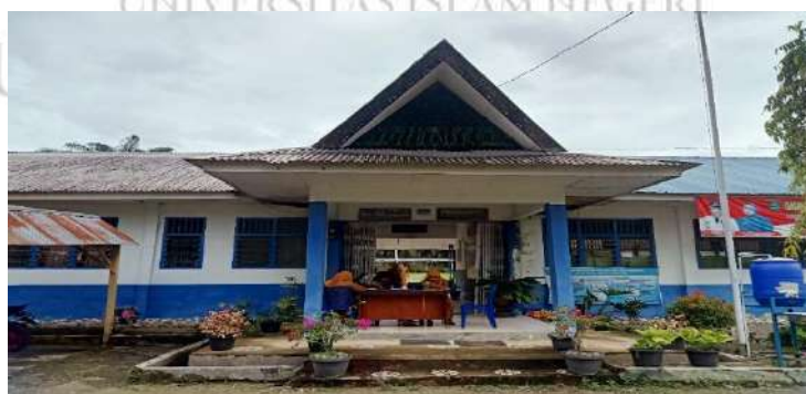
Gambar 3: Gambar gedung halaman depan dengan warna biru dan putih, dengan hiasan bunga di depan pintu masuk dan ada meja didepannya beserta beberapa guru yang sedang berbincang-bincang pada jam istirahat. Gambar di ambil pada hari rabu, tanggal 26 Oktober 2022.
