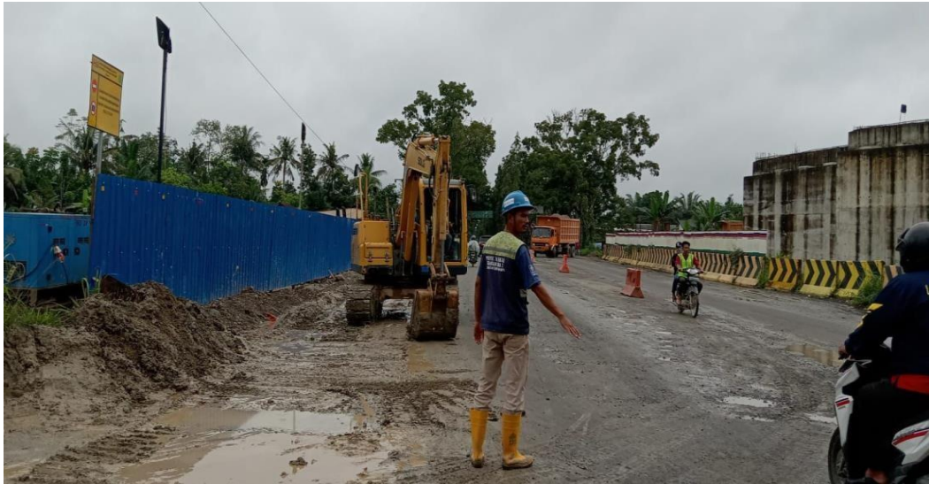
Proses pengerukan tanah menggunakan excavator
