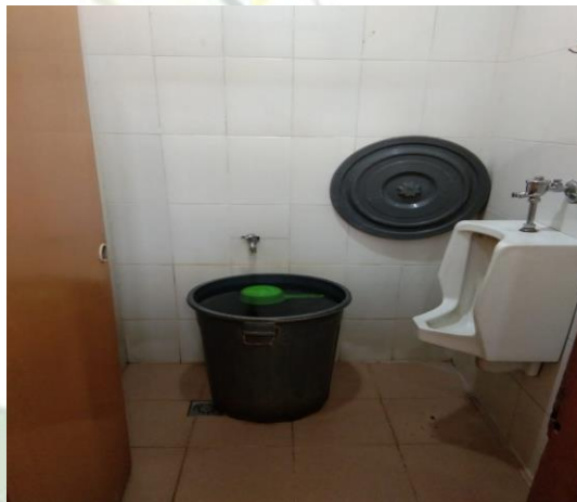
Foto Toilet Restoran Garuda
