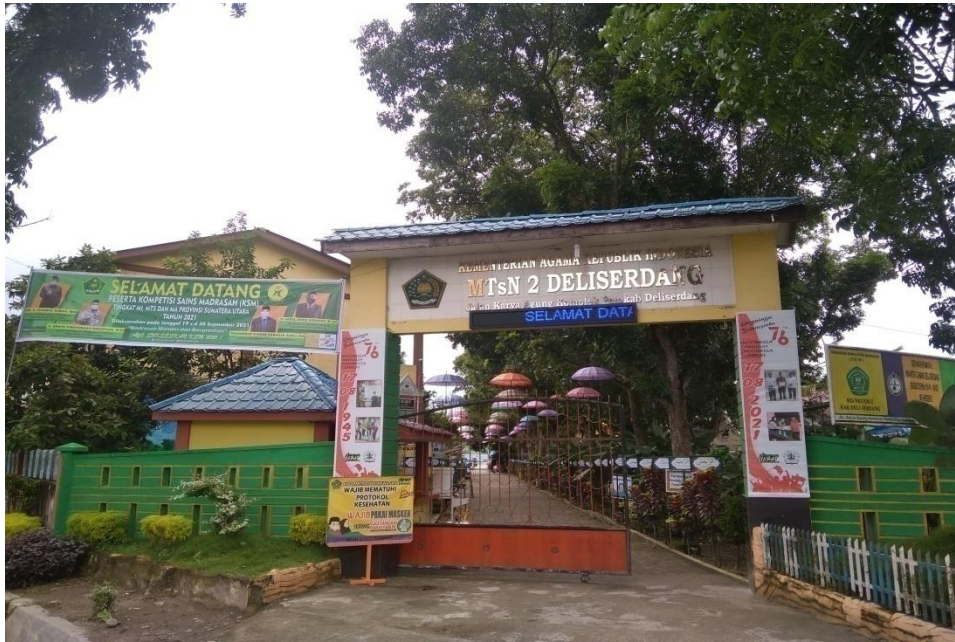
Gambar 5.1 Pintu Masuk MTsN 2 Deli Serdang
