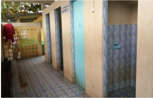
Gambar 1. Kondisi Kamar Mandi
