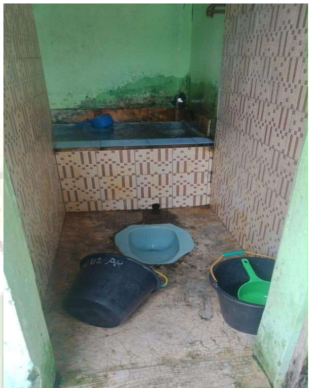
Gambar 6 Kondisi Kamar Mandi
