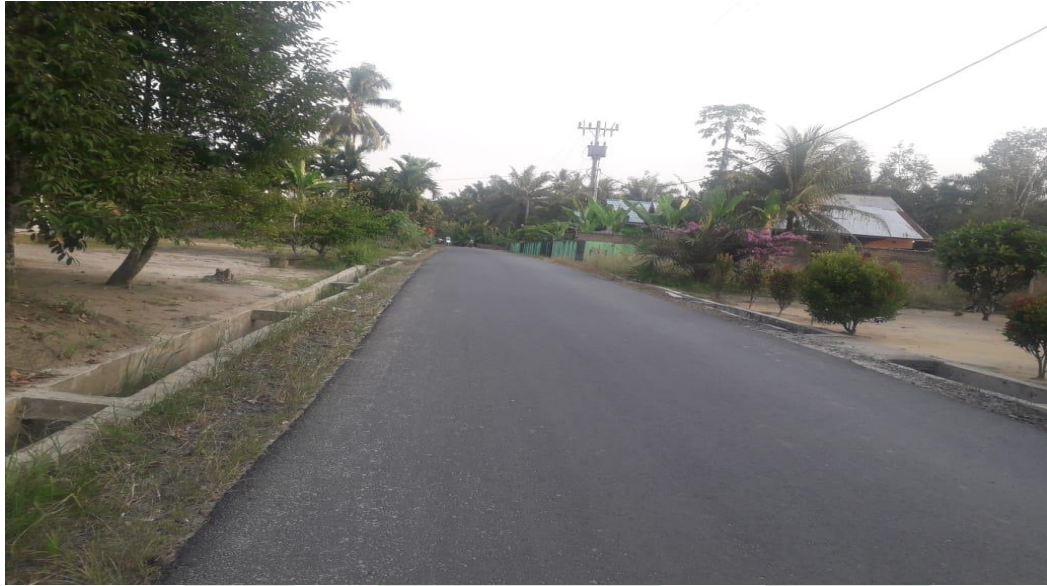
Penampakan Bangunan Jalan Desa Lubuk Cuik
