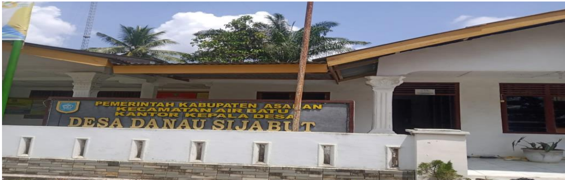
Ket: Foto Kantor Kepala Desa Danau Sijabut Kecamatan Air Batu Kabupaten Asahan tampak dari depan
