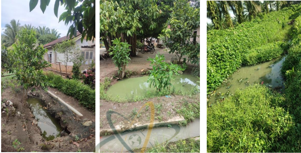
Suasana Lingkungan Desa yang Masih Menggunakan Tanah Galian yang Diserapkan Ke Tanah sebagai Sarana Pembuangan Air Limbah (SPAL)
