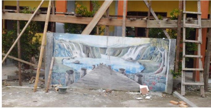
Gedung yang dalam proses pembangunan di MAN 2 DS
