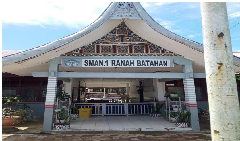
(Gambar 1. SMA Negeri 1 Ranah Batahan) Sumber: Dokumentasi Pribadi
