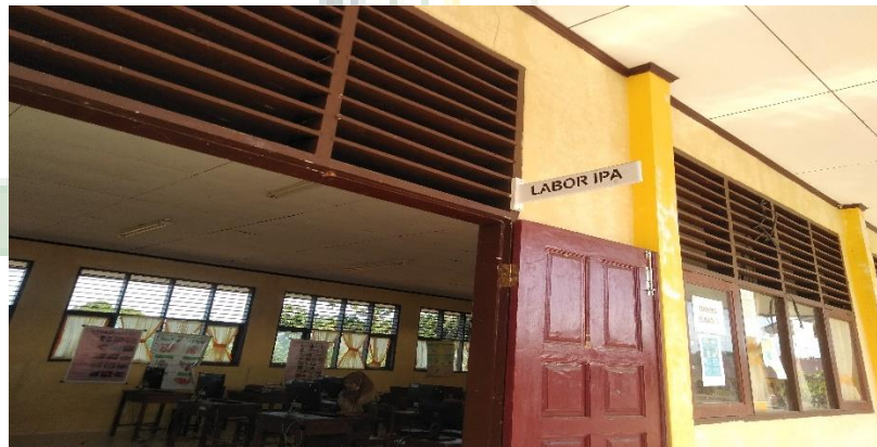
(Gambar 10. Laboratorium SMA Negeri 2 Ranah Batahan) Sumber: Dokumentasi Pribadi
