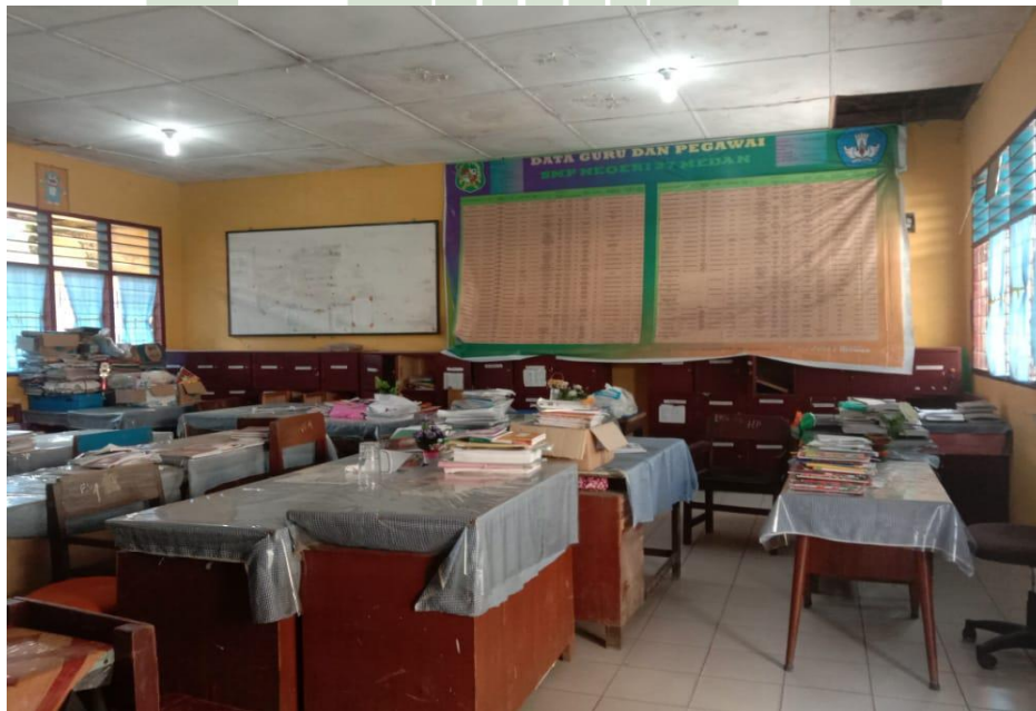
Gambar 4 Kondisi Ruang Guru
