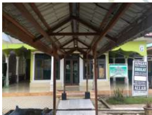
Gambar. 3 Kondisi Mushollah di SMA Negeri 1 Sei Suka Kabupaten Batu Bara
