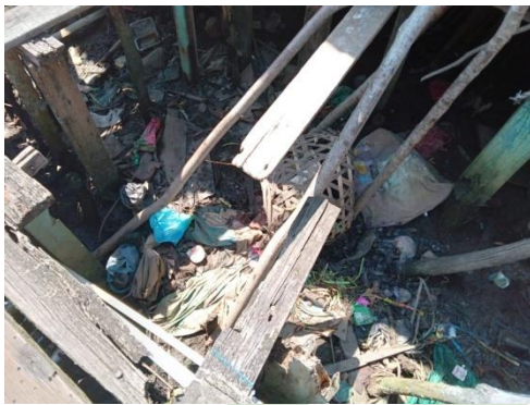
Gambar 19. Kondisi di bawah rumah panggung
