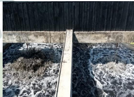
Gambar 4. Kolam aerasi saat berproses
