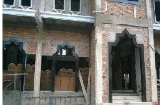
Masjid Raya Mandala Dari Salah Satu Sisi Depan (sedang tahap pembangunan)
