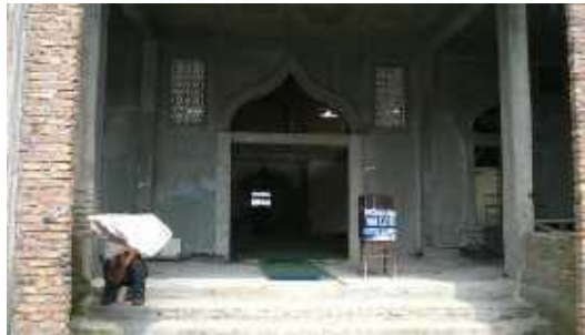
Masjid Hidayatul Islamiyah Dari Salah Satu Sisi Depan (sedang tahap pembangunan)
