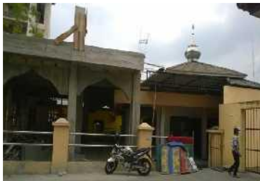
Masjid Al-Hidayah Dari Salah Satu Sisi Depan (sedang tahap pembangunan)
