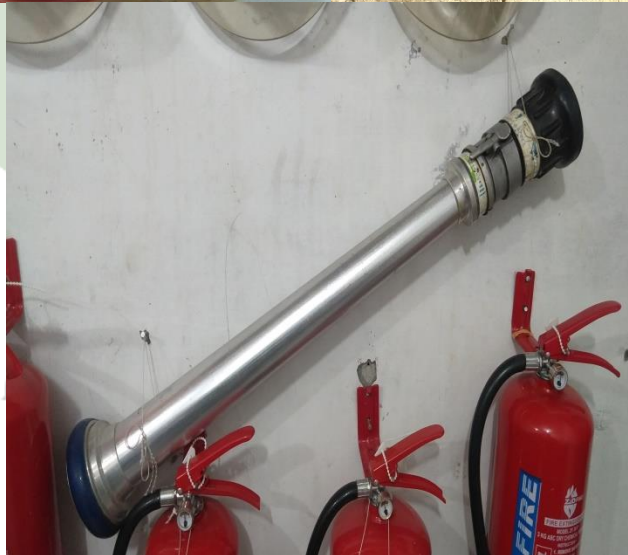
Perlengkapan Operasional Petugas Pemadam Kebakaran Selang, Tali Baja, Kepala Nozzel
