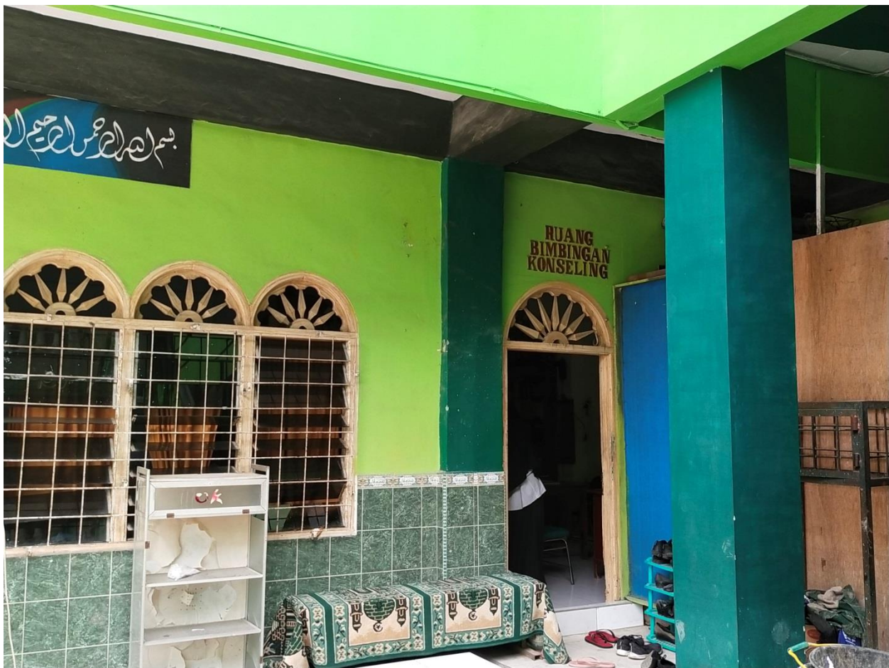
SUMATERA UTARA MEDAN Ruangan Bimbingan Konseling MTs Swasta Al-Washliyah Tembung
